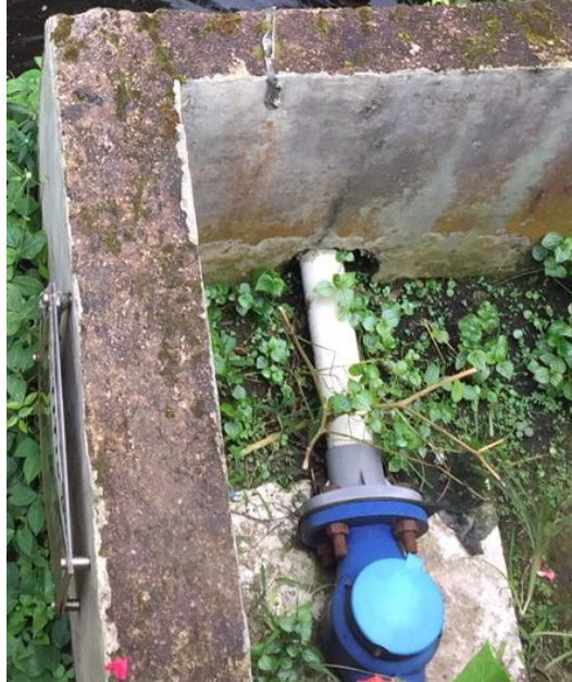
Gambar 4.25 Meteran Air untuk Mengukur Debit IPAL
