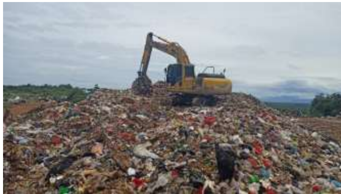
Gambar 4. 21 Proses Penimbunan Sampah di TPA Air Sebakul
