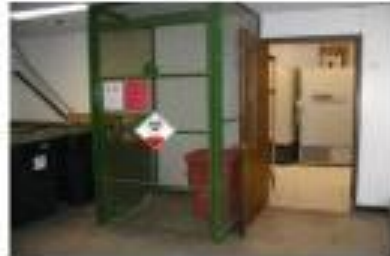
Gambar 3.5 Contoh Fasilitas Penyimpanan Limbah B3 dari Fasilitas Pelayanan Kesehatan
