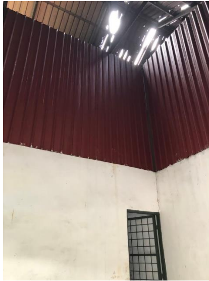
Gambar 4.29 Atap TPS Limbah Infeksius di RSBP yang Berlubang
