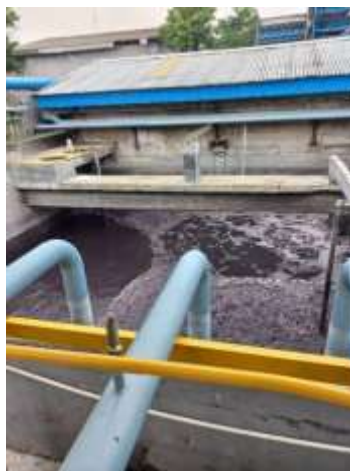
Gambar 5. 26 Bak Denitrifikasi di IPAL PT X
