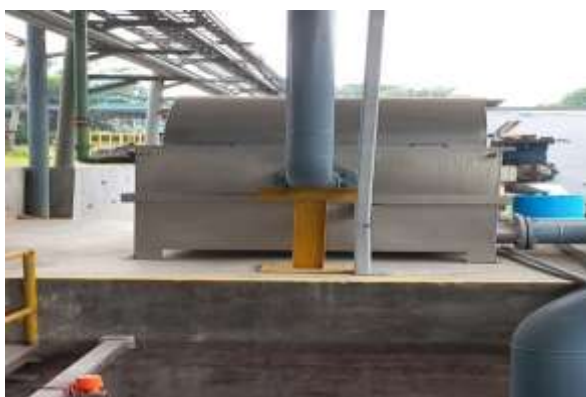
Gambar 5.13 Conoscreen di IPAL PT X
