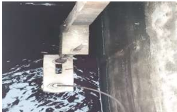
Gambar 5. 9 Flow meter di IPAL PT X
