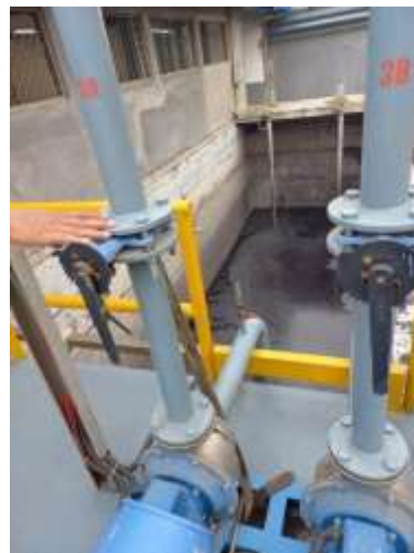
Gambar 5. 24 Dosing Pump di Bak Ekualisasi IPAL PT X
