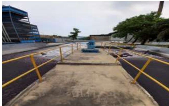
Gambar 5. 42 Bak Aerasi II di IPAL PT X
