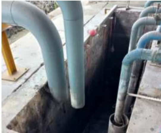
Gambar 5. 14 Grease Trap di IPAL PT X
