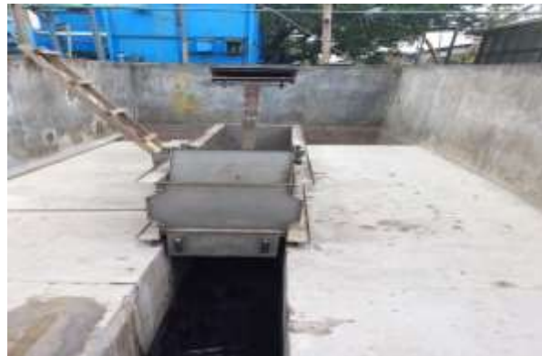
Gambar 5. 6 Fine Screen di PT X
