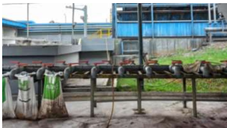
Gambar 5. 53 Bag Filter dan Keran Lumpur IPAL PT X
