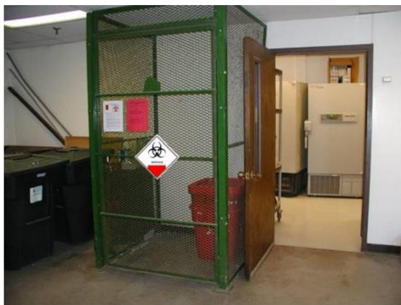
Gambar 2. 2 Contoh Fasilitas Penyimpanan Limbah B3 dari Fasilitas Pelayan Kesehatan dalam Ruangan yang dilengkapi dengan Pembatas Akses (Kerangkeng)
