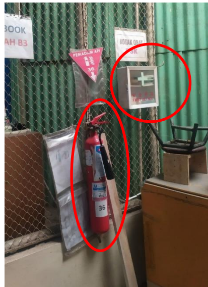
Gambar 4. 1 Alat Pemadam Kebakaran dan Kotak P3K di TPS PT Nikkatsu Electric Works
