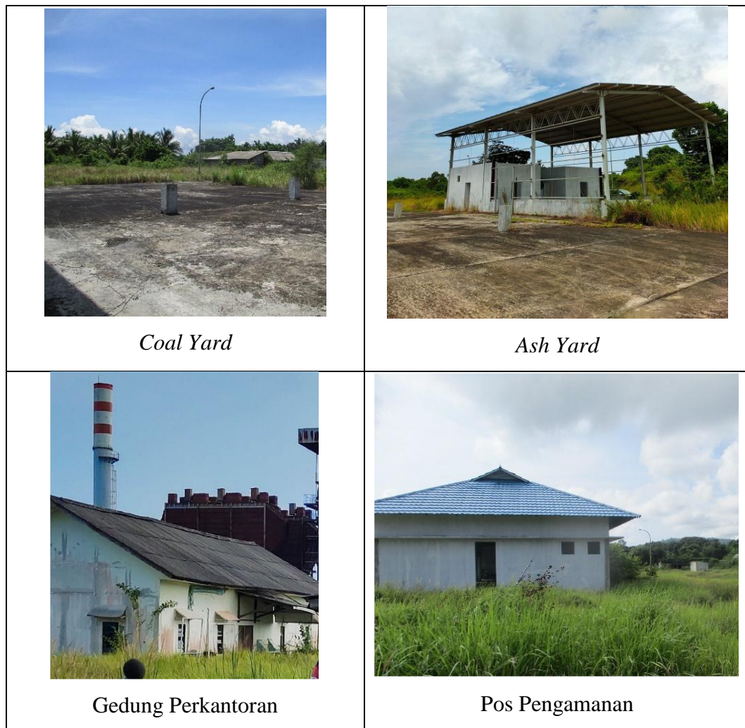
Gambar 3.4 Dokumentasi Kondisi Eksisting PLTU Kotabaru (2X7 MW)
