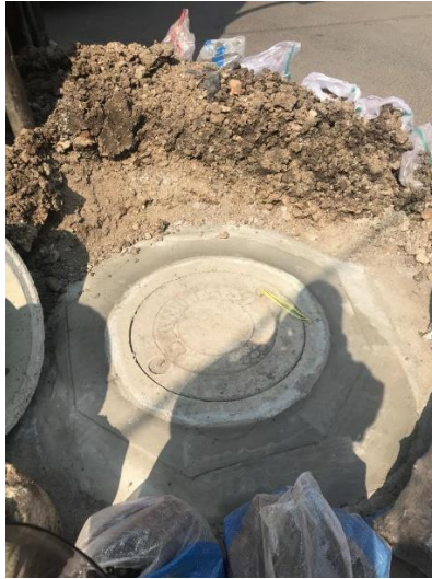
Gambar 4.5 Pemasangan Manhole
