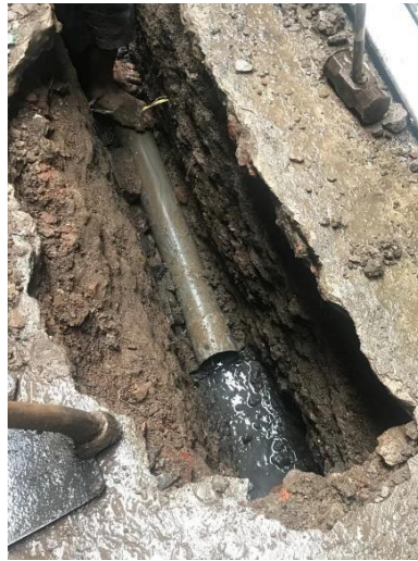
Gambar 4.3 Pemasangan Pipa Air Limbah
