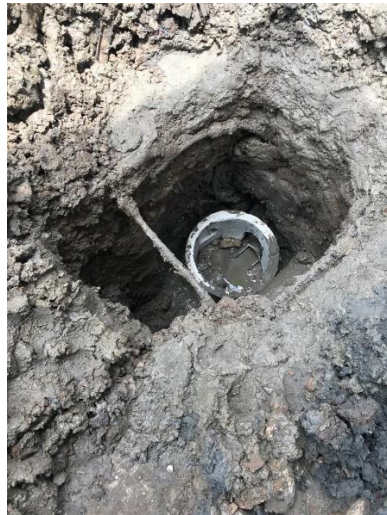
Gambar 4.6 Proses Pemasangan Manhole
