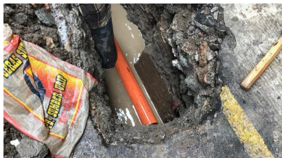
Gambar 4.2 Proses Pemasangan Pipa Air Limbah Domestik
