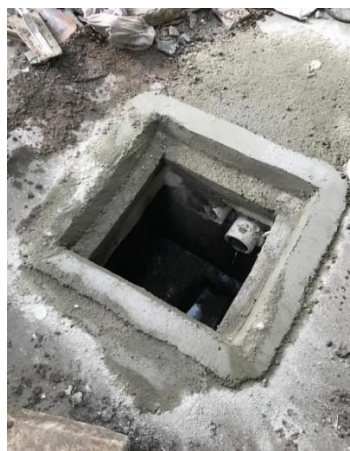
Gambar 4.4 Pemasangan Manhole
