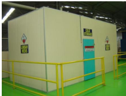
Gambar 3 . 3 Contoh Ruang Pendingin Untuk Limbah Infeksius, Benda Tajam, dan/atau Patologis
