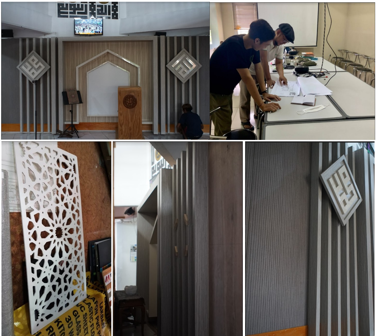
Gambar 5. Dokumentasi Proses Koordinasi dan Konstruksi di Lapangan
