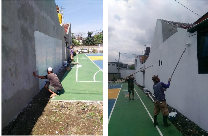
Gambar 1. 20 Proses Pengecatan Warna Dasar
