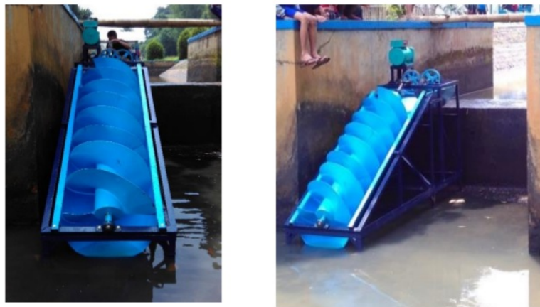
Gambar 9. Proses Pemasangan dan Pengujian Turbin di Lokasi
