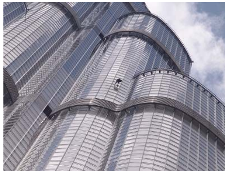
Gambar 12 “Pemanjat tebing” yang berprofesi sebagai pembersih kaca jendela atau sebaliknya [foto koleksi penulis, survei Burj Khalifa 2014].
