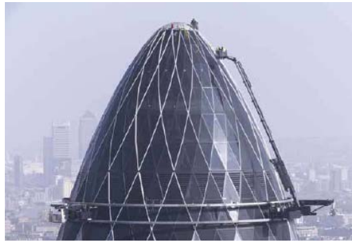
Gambar 11 Alat pembersih jendela lantai atas (gondola)
