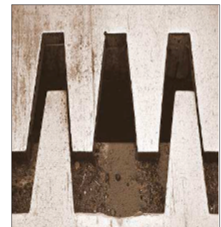
Gambar 7.20 - Putusnya "finger" pada siar muai
