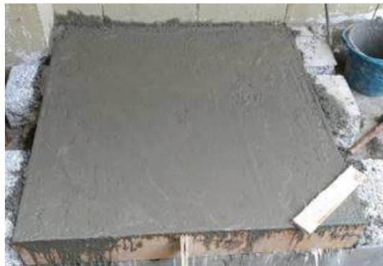
Gambar 8. Proses pengisian lapisan kulit terakhir dan pemerataan permukaan pelat floating concrete
