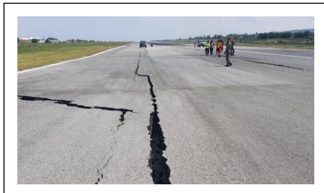
Gambar 1. 1 Kondisi Perkerasan Landas Pacu Setelah Gempa
