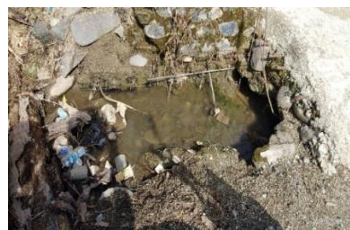
Gambar 2. Kondisi Saluran Drainase
