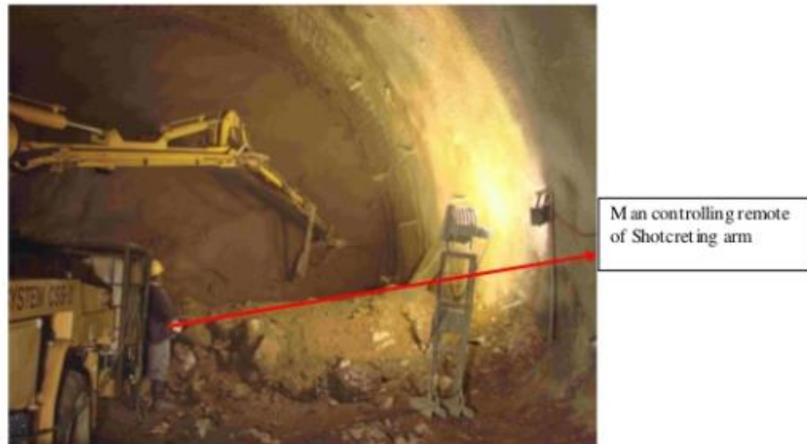
Gambar 2.9 Tahap pemasangan primary lining dengan shotcrete (Sumber : Hamed, 2015)
