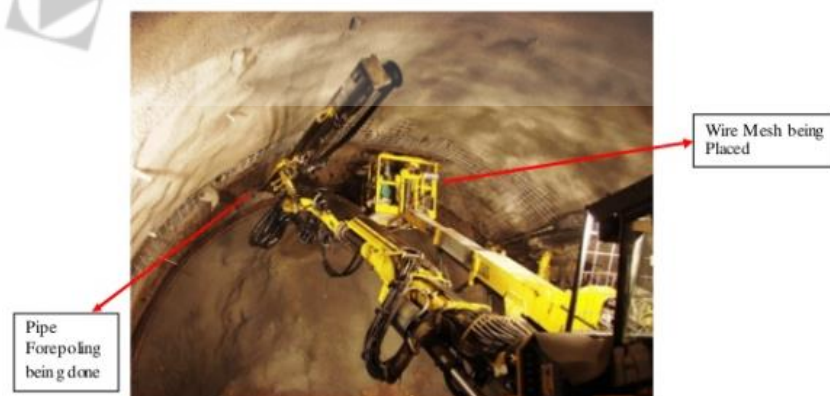
Gambar 2.8 Tahapan perbaikan wire mesh dan pipe forepoling
