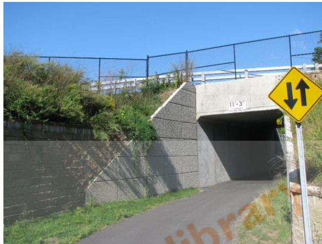
Gambar 2.2 Bentuk Terowongan Persegi (Sumber : Wally, 2014)
