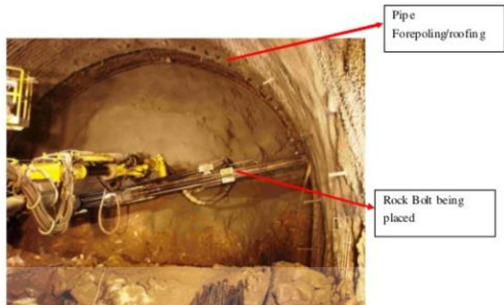
Gambar 2.10 Tahap pemasangan rock bolt
