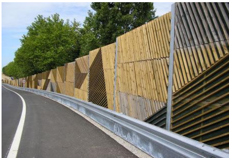
Gambar 2.18 Barrier pada Sisi Jalan Raya
