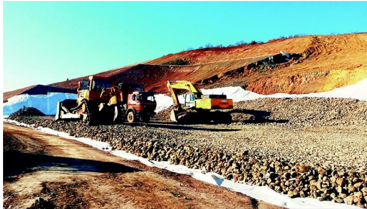
Gambar 2.1 Pengerjaan Timbunan Menggunakan Bahan Rockfill
