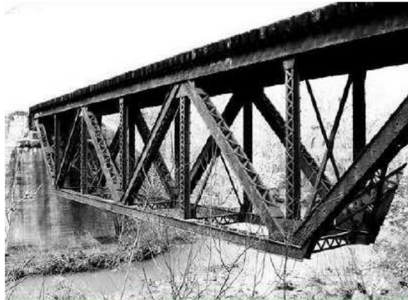
Gambar 2.1 Jembatan kereta api tipe rasuk/dek
