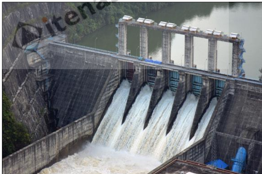
Gambar 2.2 Bangunan pelimpah berpintu Bendungan Sei Gong di Kepulauan Riau
