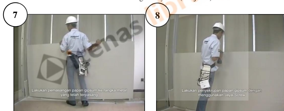
Gambar 2.11 Pasangan Drywall (Lanjutan)
