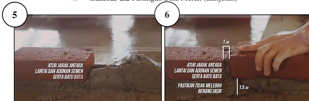
Gambar 2.3 Pasangan Bata Merah (Lanjutan)
