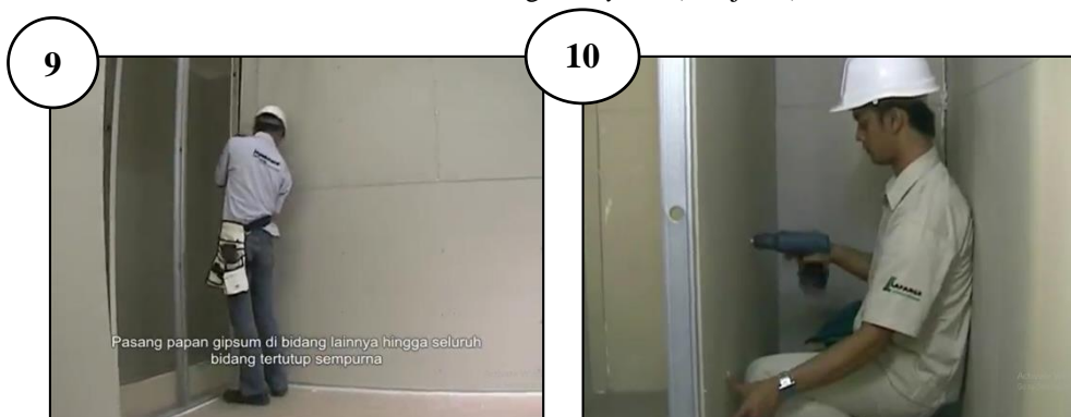
Gambar 2.12 Pasangan Drywall (Lanjutan)
