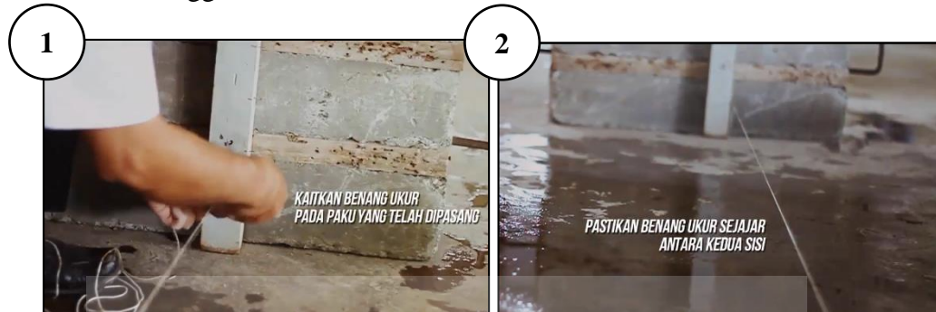
Gambar 2.1 Pemasangan Bata Merah.
