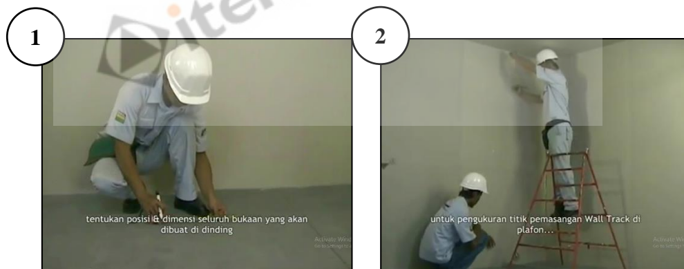
Gambar 2.9 Pasangan Drywall
