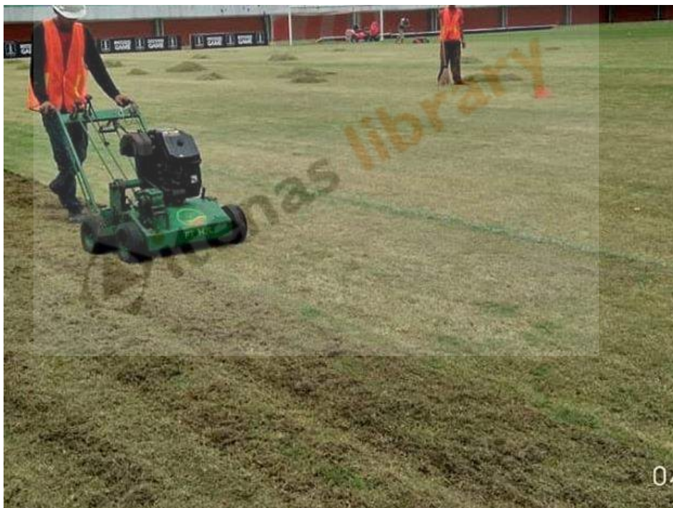
Gambar 2.7 Pembajakan Rumput Dengan Cara Verticut (Sumber : Dokumen PT. Lestarindo)
