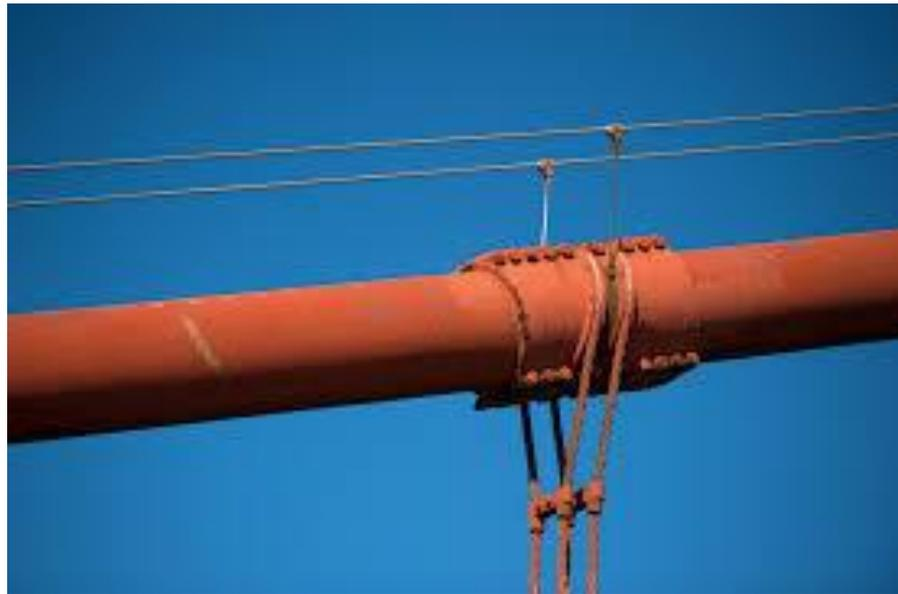
**Gambar 2.4** kabel utama pada jembatan *golden gate*
