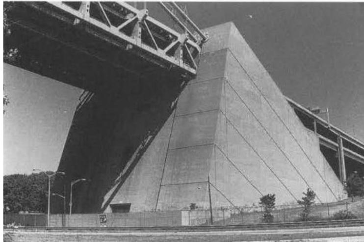
**Gambar 2.13** Blok jangkar *Verrazano Narrows Bridge* sepanjang 1298 m
