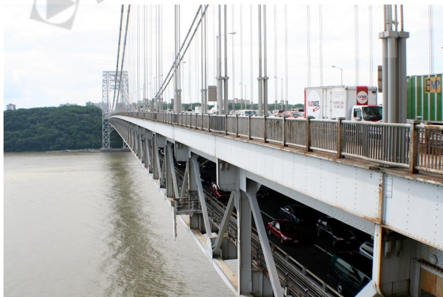
Gambar 1.5 Peningkatan kapasitas jalan dengan sistem dek ganda
