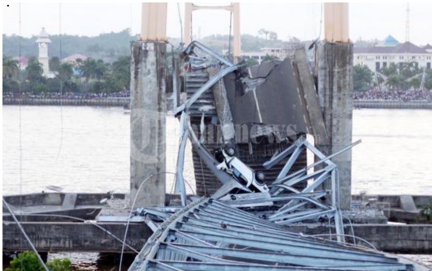
Gambar 1.4 Kegagalan struktur pada jembatan Kukar, Kutai Kartanegara Sumber : www.tribunnews.com
