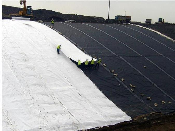
**Gambar 2.7** Pengaplikasian Geotekstil pada Lereng
