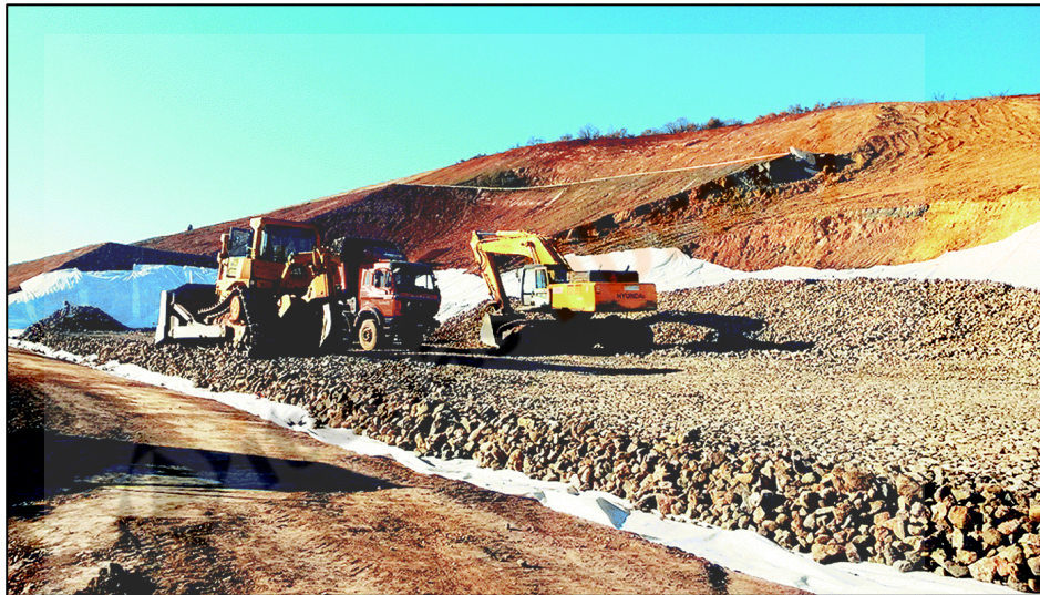
Gambar 2.2 Pekerjaan Timbunan Badan Jalan Dengan Rock Fill
