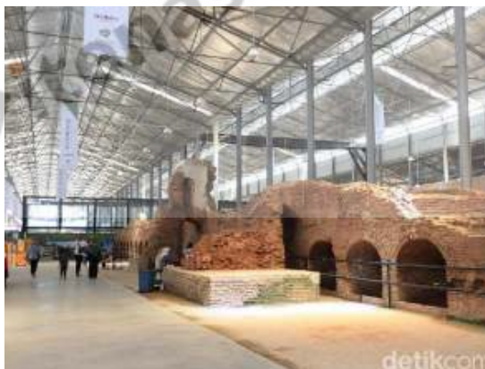
Gambar 2.13 Struktur Baja pada Rest Area 260B Banjaratma
