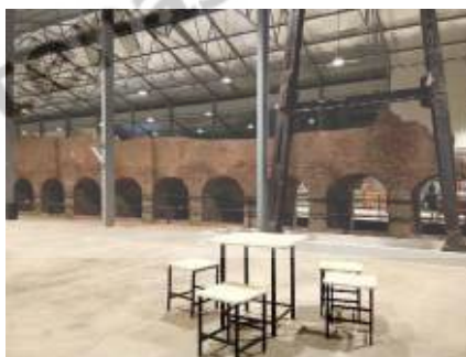
Gambar 2.14 Kolom, Balok dan Plat Lantai pada Rest Area 260B Banjaratma
