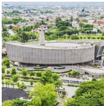
Gambar 2.8 : Museum Tsunami di Nanggroe Aceh Darussalam Sumber : https://www.grid.id/read/041275647/14-tahun-tsunami-aceh-bangkai-truk-hingga-helikopter-di-museum-ini-jadi-saksi-dahsyatnya-gelombang-yang-menyapu-tanah-rencong?page=all , diakses pada 15 September 2020
