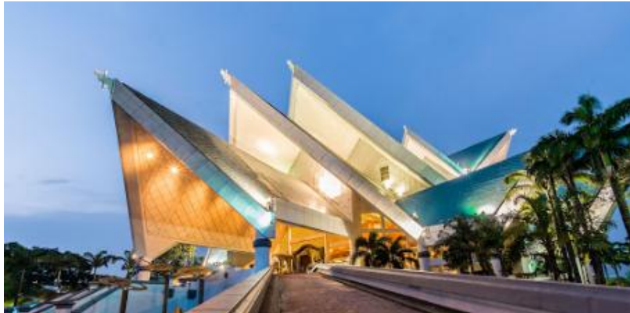
Gambar 2.20 Bangunan Istana Budaya Malaysia
