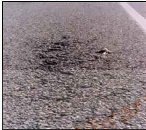
Gambar 2.4 Pelepasan Butiran ( Weathering/Raveling ).
