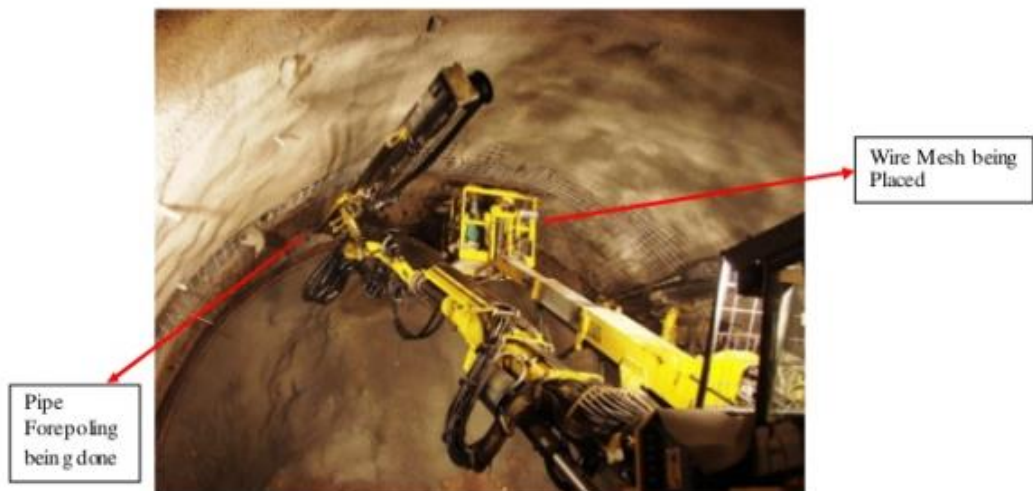
Gambar 2.5 Tahapan perbaikan wire mesh dan pipe forepoling (Sumber : Hamed, 2015)
