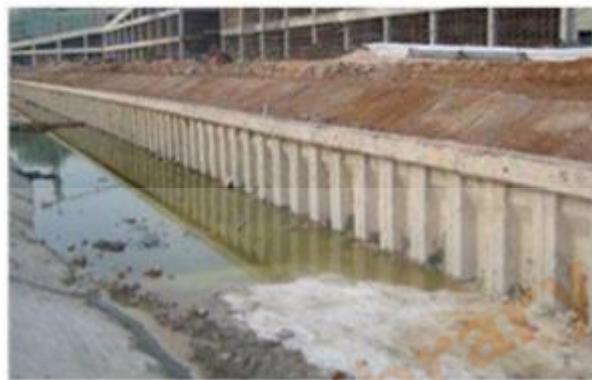
Gambar 2.4 Aplikasi Turap Beton Pada Sungai/ Kanal
