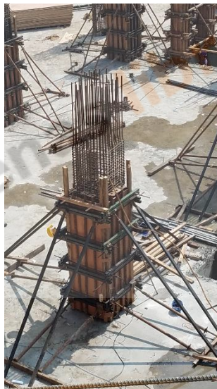
Gambar 2.11 Bekisting Kolom
